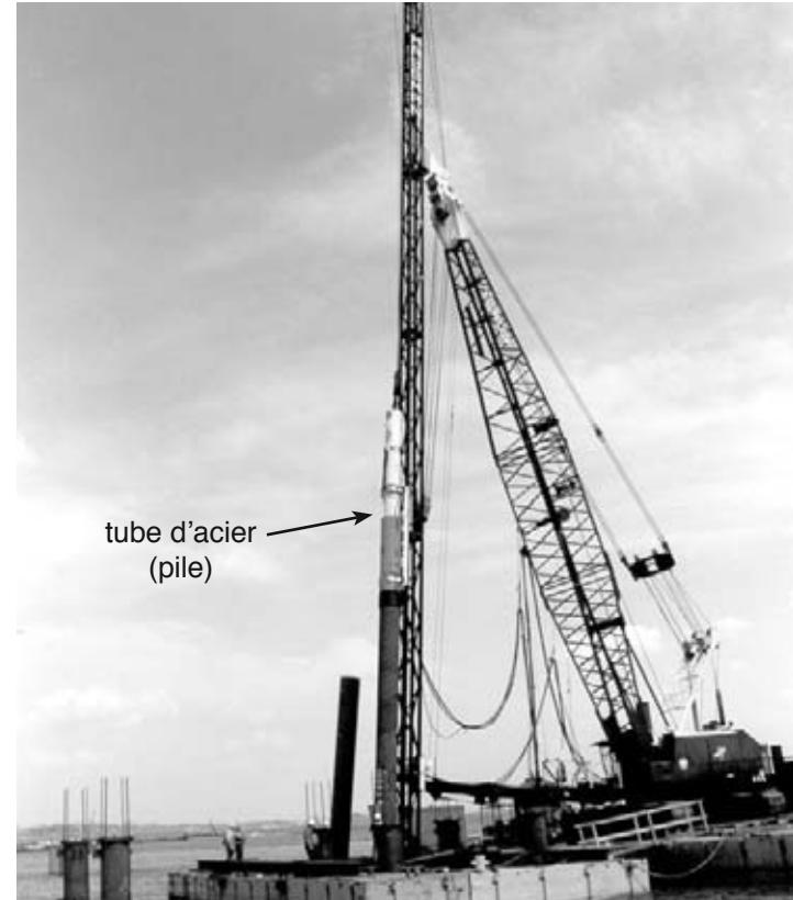
Des tubes d'acier sont enfoncés dans le fond de la rivière
