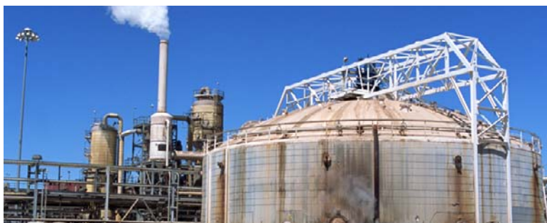
Des centrales pourraient servir de renforts aux fermes solaires.
