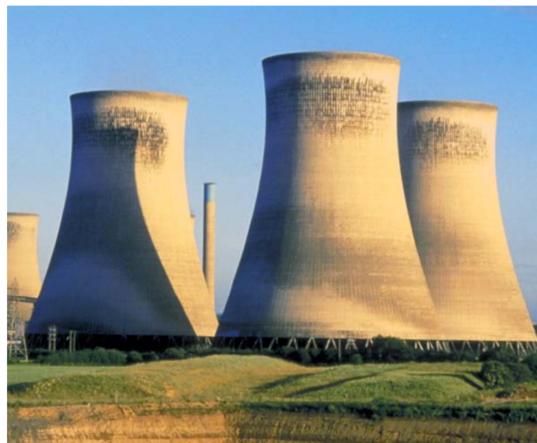
Des tours de refroidissement (tours aéroréfrigérantes) maintiennent le cœur d'une centrale nucléaire à une température sécuritaire.
