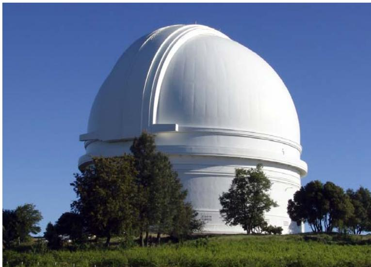
Ce bâtiment abrite le télescope du mont Palomar. Le dôme s'ouvre quand le télescope est utilisé.
